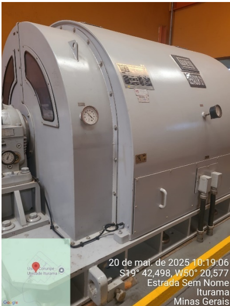
Alternator/ Generator nº 1 (UTE Coruripe Energética Iturama)
