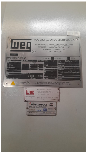
Nameplate data: Alternator/ Generator nº 1 (UTE Coruripe Energética Iturama)
