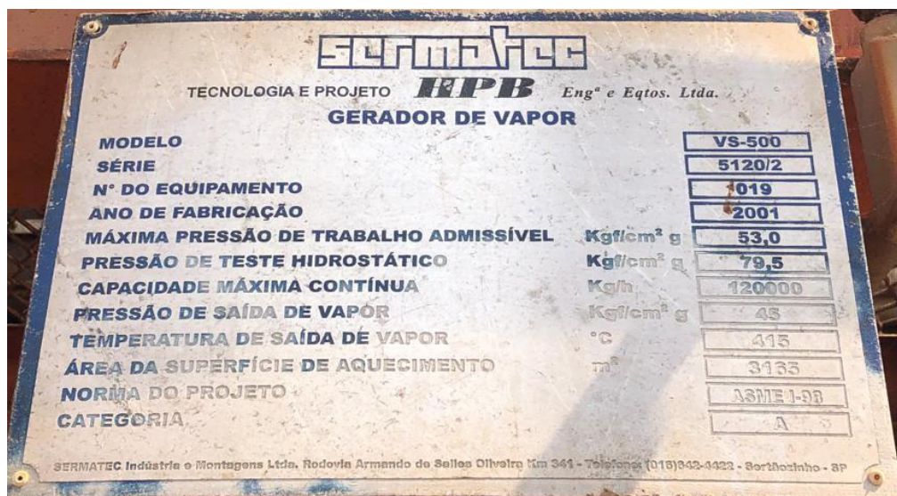
Nameplate data: Boiler nº 1
