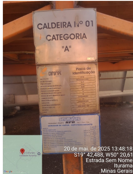
Nameplate data: Boiler nº 1 Iturama
