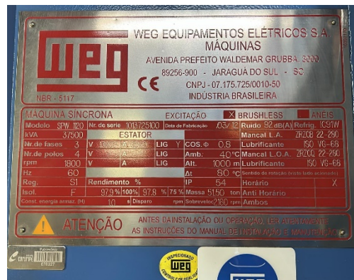
Nameplate data: Alternator/ Generator nº 2 (UTE Coruripe Campo Florido)
