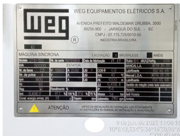
Nameplate data: Alternator/ Generator n° 6 (UTE Coruripe CVW Energética)
