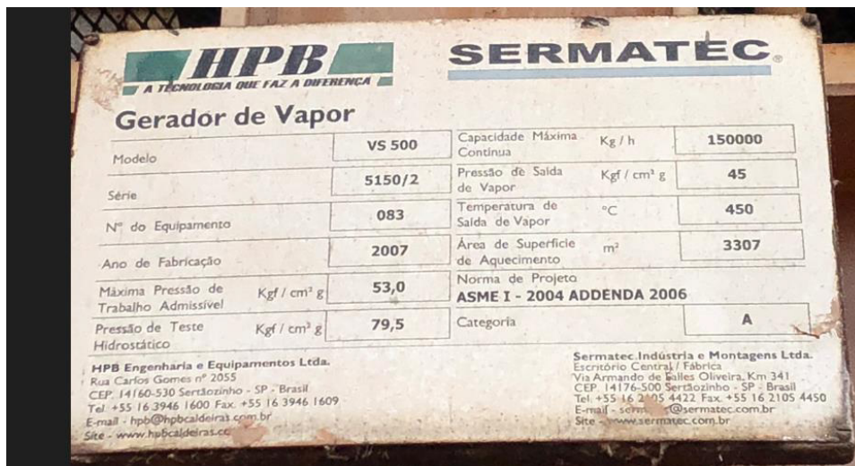
Nameplate data: Boiler nº 3
