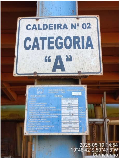
Nameplate data: Boiler nº 2
